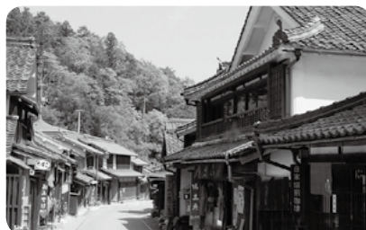
吹屋、ベンガラの町並み
